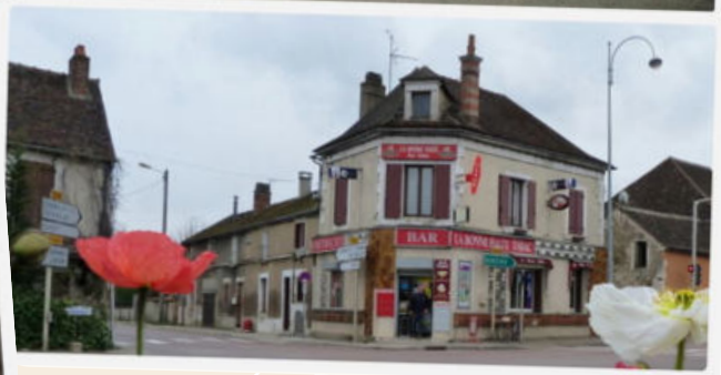
Nationale 6 - Rue du Pont
